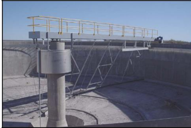
Figura 12 Vista del interior del Sedimentador Secundario.
