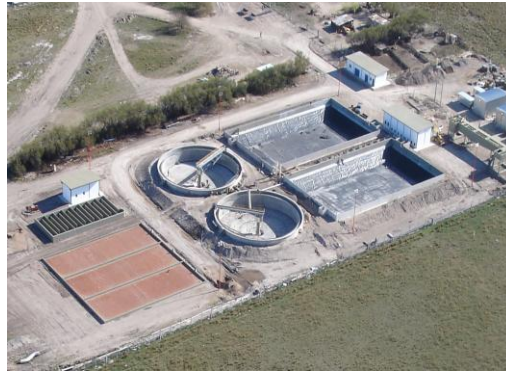
Figura 3. Vista Panorámica de la Planta Depuradora.
