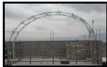
Fig. 8. Vista Lateral de la Estructura
