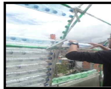
Fig. 7. Implementación Estructural del Invernadero con Botellas PET
