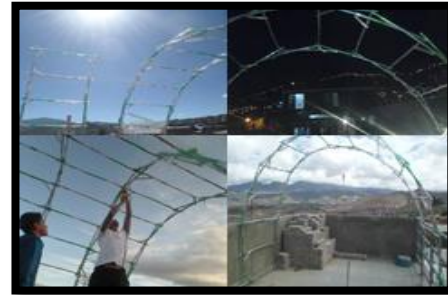
Fig. 6. Implementación Estructural Superior del Invernadero
