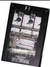
Fotografía. 1 Ejemplo de relevador electromecánico instalado en los SEP de la INR
