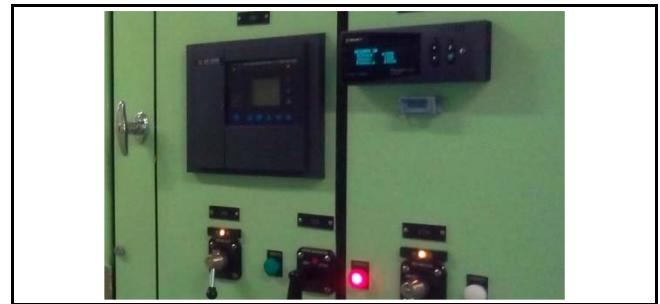
Fotografía. 2 Ejemplo de relevador digital instalado en los SEP de la INR
