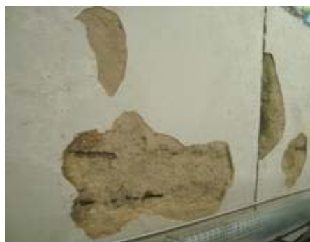
Figura 10. Inspeção visual na face inferior da laje em estudo: causas intrínsecas – falhas humanas durante a utilização.
