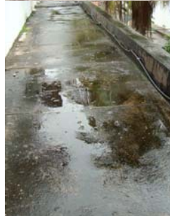
Figura 5. Inspeção visual na face superior da laje em estudo: causas intrínsecas – falhas humanas durante a construção.
