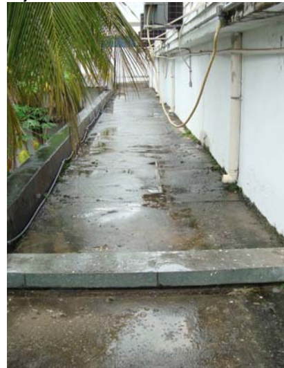
2b – Vista da face superior da laje em estudo
