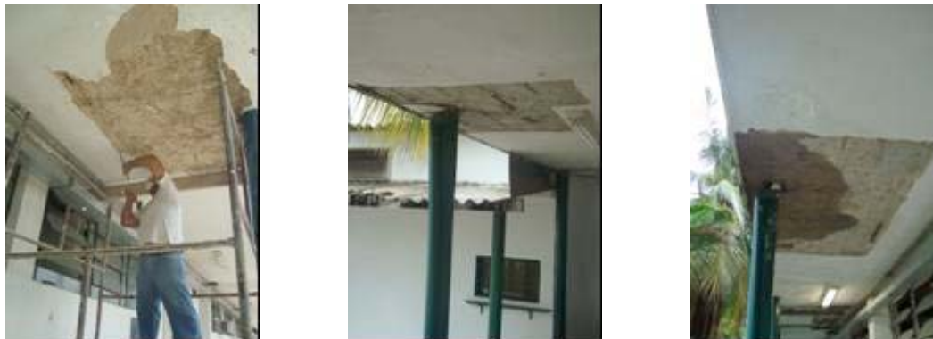
Figura 12. Remoção do revestimento da laje para realização de ensaios não-destrutivos
