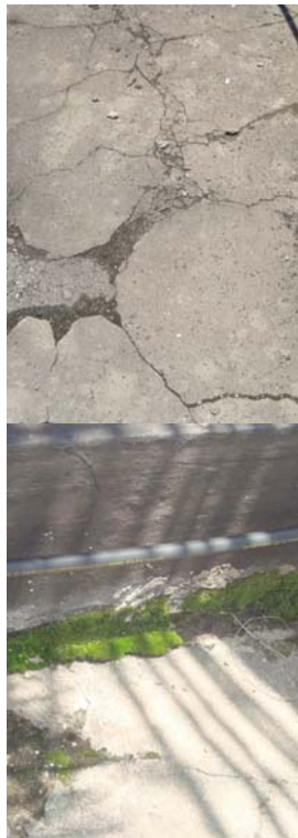
Figura 7. Inspeção visual na face superior da laje em estudo: causas intrínsecas – causas naturais
