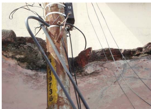
Foto 05 - Corte na M02 para colocação de poste de iluminação
