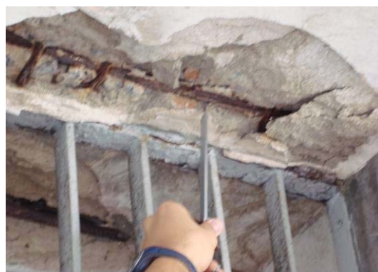
Foto 02 - Medição do cobrimento nominal com paquímetro
