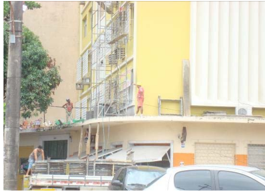
Foto 07 – Detalhe da reforma com homens, andaimes e materiais de construção em cima da M03.
