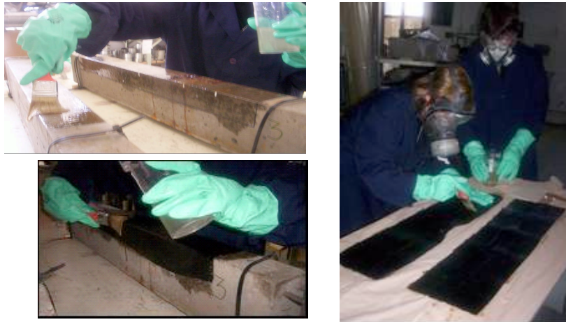
Figura 6: Técnica de refuerzo y/o reparación con polímeros reforzados con fibras de carbono
