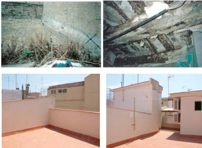
Figura 14. Imágenes de la misma cubierta antes de ser intervenida y luego de la intervención.
