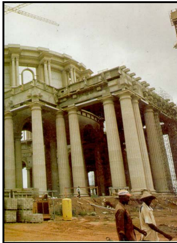
Figura 12: Processo construtivo da basílica de Nossa Senhora da Paz na Costa do Marfim – concreto armado e concreto pré-moldado [1]
