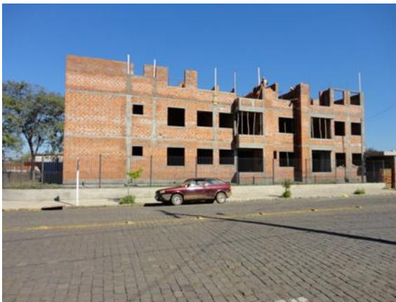
Figura 3 Vista de la fachada principal de la obra.
