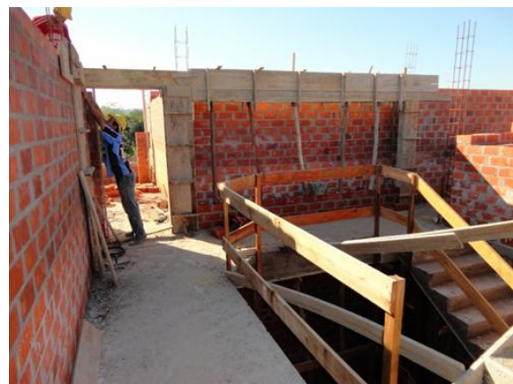
Figura 6 La madera utilizada en la obra.
