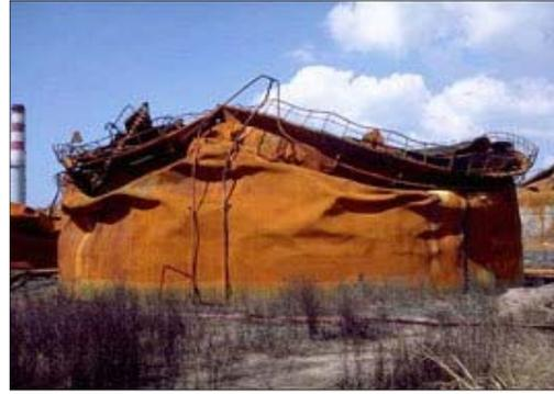
Figura 6 Daño ocasionado por el fuego a los tanques de nafta de la refinería Tüpras. Sismo de Kokaeli 1999.
