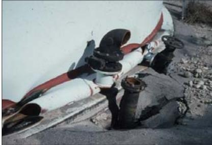
Figura 11 Falla en la tubería.
