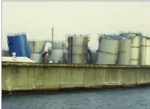
Figura 7 Tanque dañado por el sismo de Kobe en 1995.
