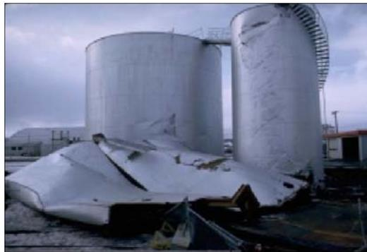
Figura 4 *Colapso de tanque de almacenamiento.*
