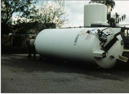
Figura 5 Tanque vertical en el hospital que debido a la falta de anclaje se volcó durante el terremoto de Northridge 1994.
