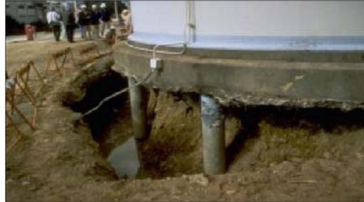
Figura 12 Falla de la cimentación por licuefacción.
