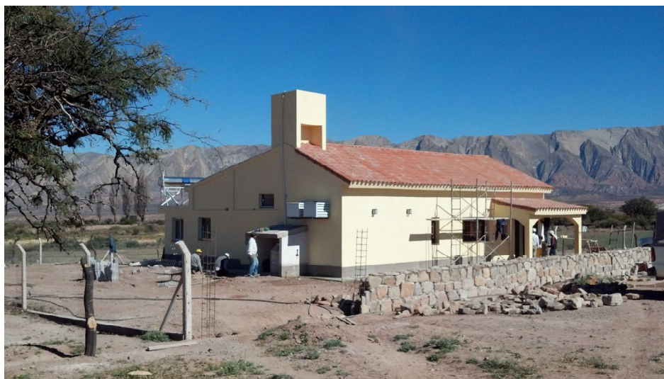
Figura 3: Fachada de la Planta de Elaboración de Quesos en Amblayo
