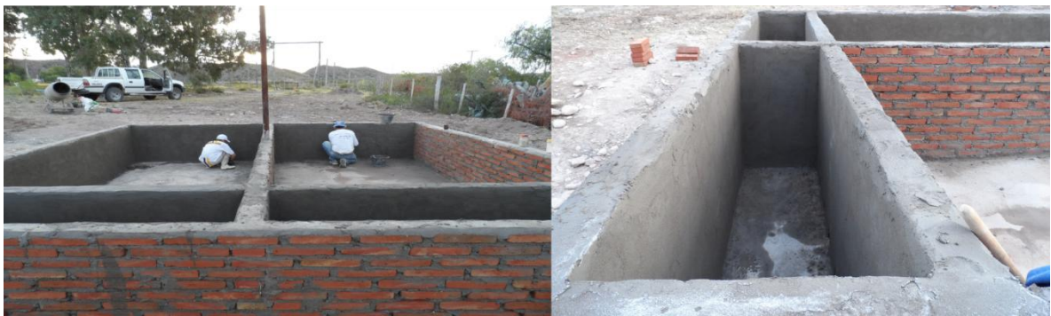
Figura 3 Construcción de MDV.
