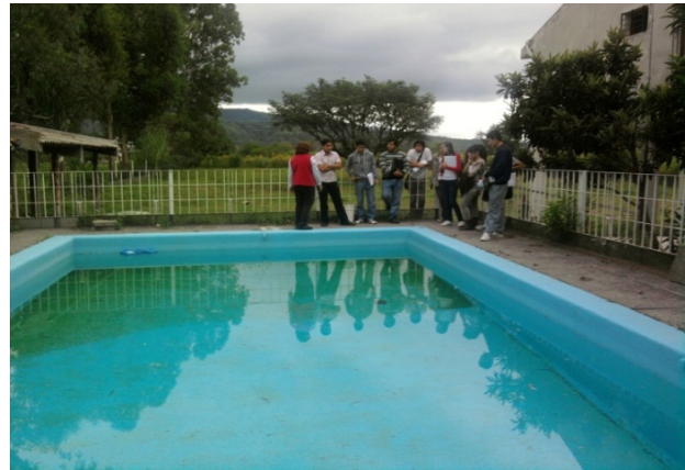
Figura 7: Piscina calefaccionada por recirculación de agua en bolsa negra.
