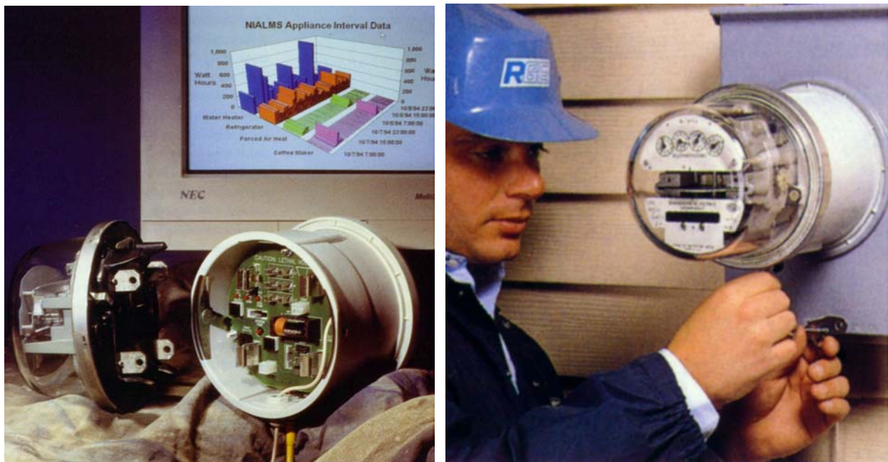
Figura 11. Sistemas de Monitoreo de Carga Domiciliarias No Invasivo (NIALMS): detalle e instalación.
