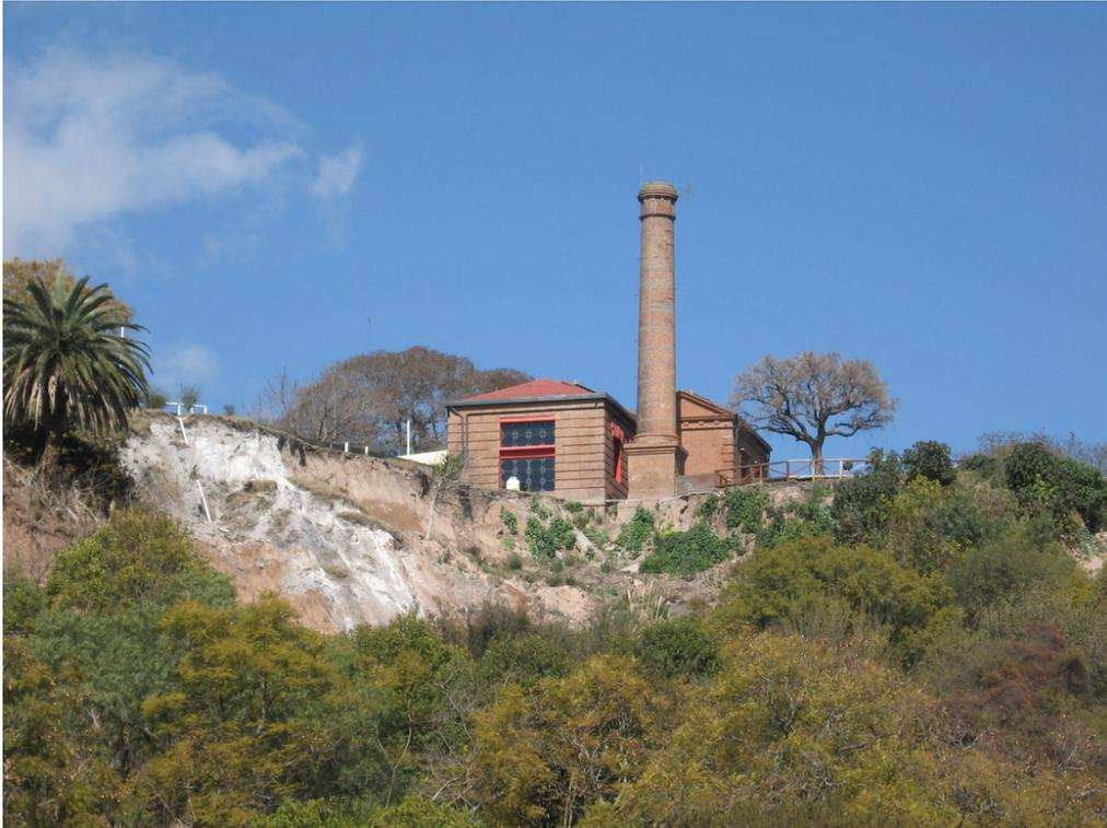
Figura 1-7. Construcción en riesgo por deslizamiento rotacional
