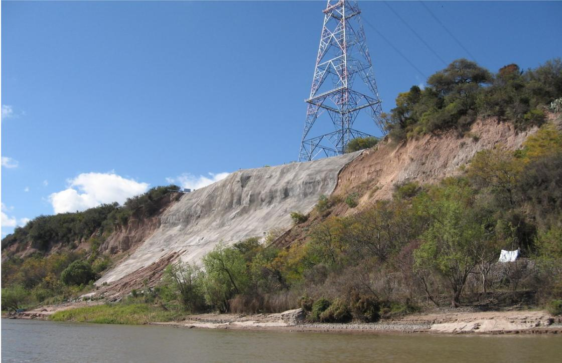
Figura 1-2. Zona crítica bajo una torre de 500kV proveniente de Salto Grande
