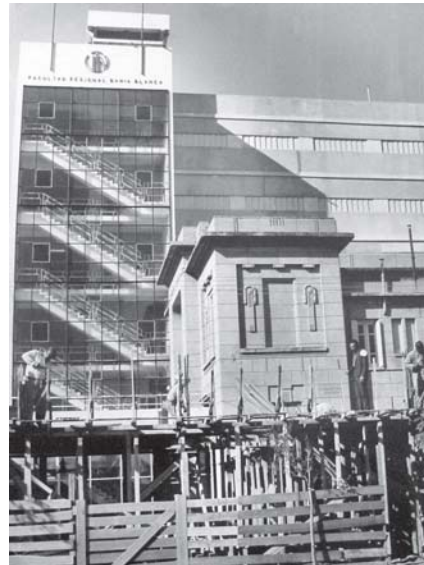
Construcción de la segunda torre, 1968.
