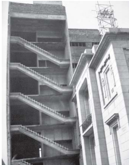
Las obras en marcha, 1967.
