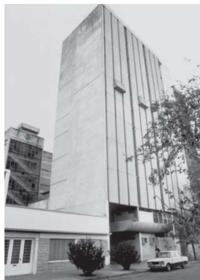
Edificio de la FRBB sobre calle 11 de abril
