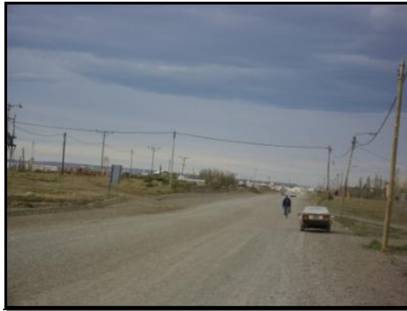
Fotografía : Cruce de líneas de alimentación eléctrica
