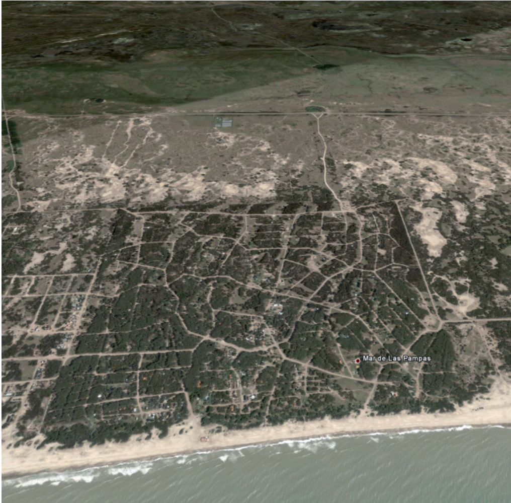
Fig. 3. Mar de las Pampas: vista aérea de caminos
