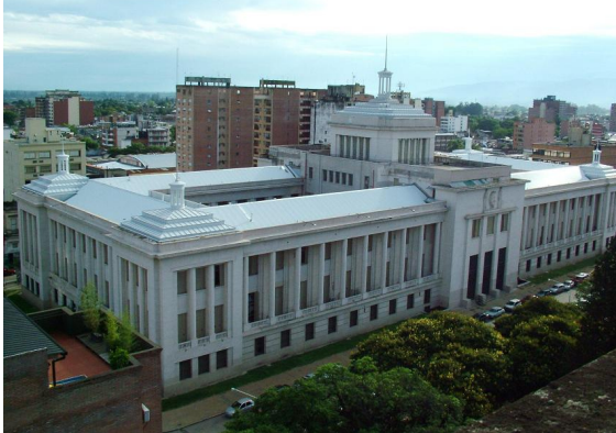
Fig. 1: Edificio del Palacio de Tribunales de la ciudad de San Miguel de Tucumán.
