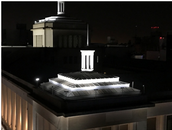
Fig.8 Detalle de Chapitel y linterna esquinera vista desde edificio de enfrente.
