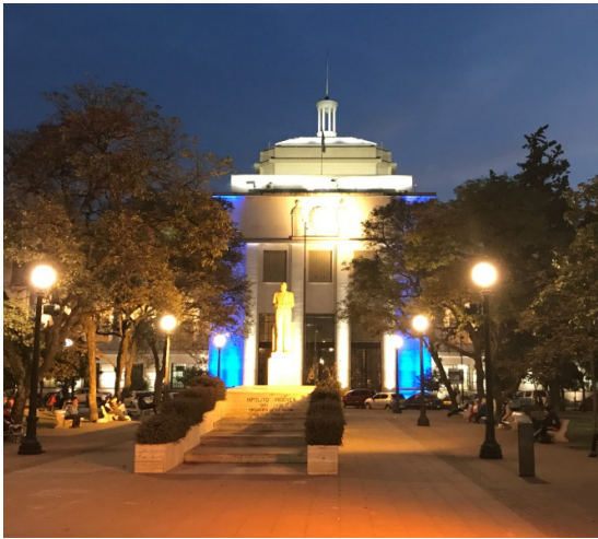
Fig.7 Fachada de portico principal vista desde la plaza
