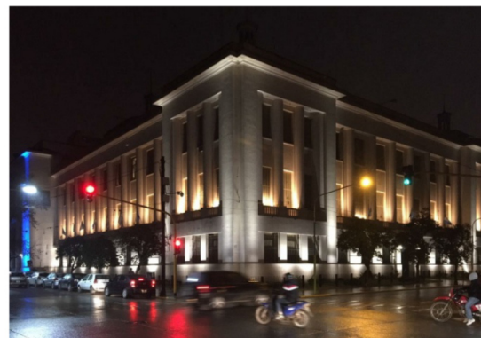
Fig. 6: Fachada de esquina
