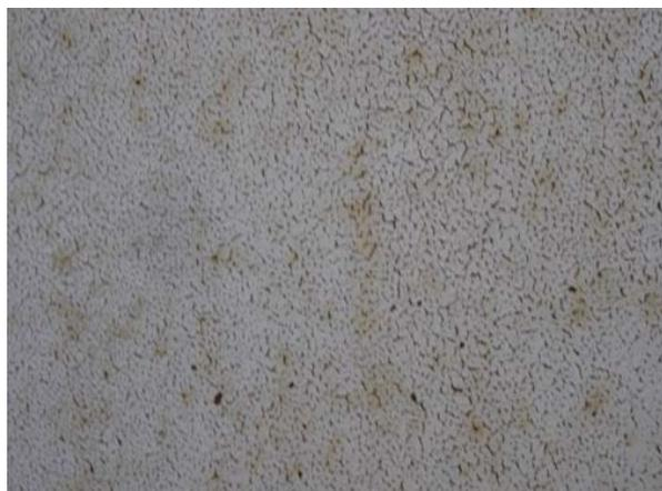
**Figura XII.7. Macroagrietado con corrosión metálica del sustrato**
