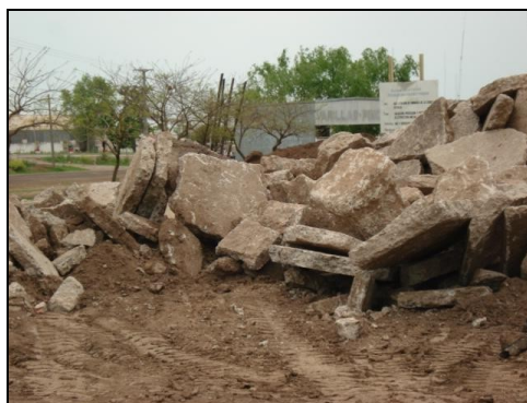
Figura 1. Roturas de pavimentos rígidos
