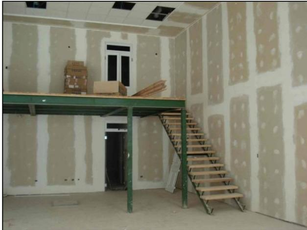
**Figura 7.1.** Yeso aplicado en condiciones secas (YS) como revestimiento de paredes y cielorrasos, mediante PYL.
