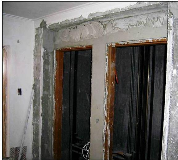
**Figura 7.3.** Yeso aplicado en condiciones húmedas (YH) como revestimiento de paredes y cielorrasos.
