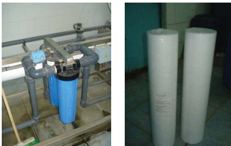
Figura N° 20 Cartuchos de filtro OI (Fuente: Álbum propio; tomado de la planta de OI de Coronel Dorrego)
