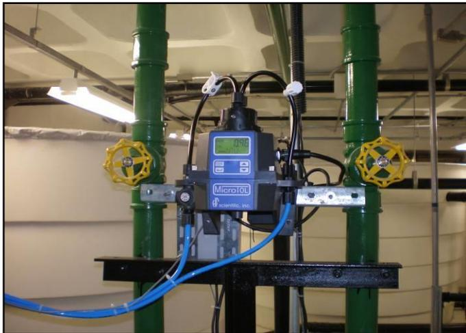
Figura 3 – Automação (Turbidímetro on-line)
