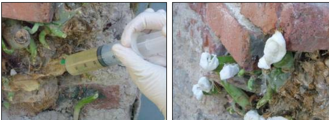
Figura 22 y Figura 23: Inyección del herbicida y taponamiento
