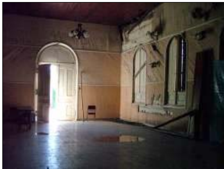
Figura 49: Interior del teatro inundado por la lluvia
