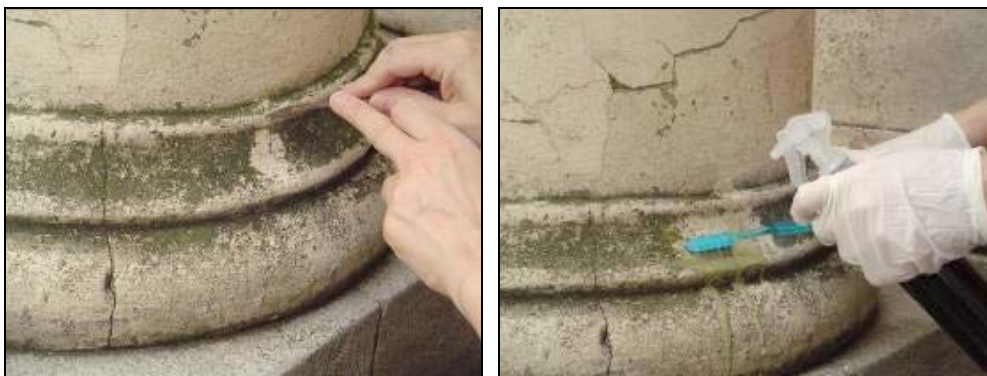
Figura 40 y Figura 41: Limpieza mecánica y química
