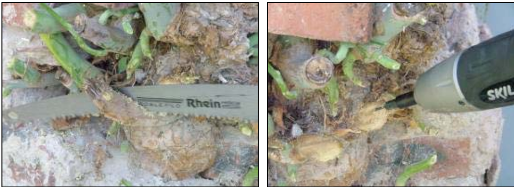
Figura 20 y Figura 21: Corte de las ramas principales y trabajo de perforación
