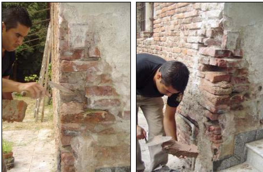
Figura 31 y Figura 32: Reposición de ladrillos.
