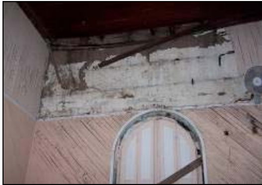
Figura 47: Esquina colapsada
