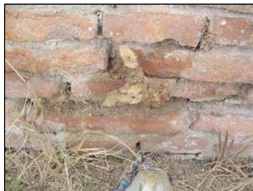
Figura 36: Verificación de estado
