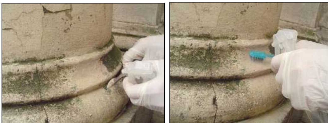
Figura 42 y Figura 43: Limpieza mecánica en superficie húmeda y enjuague
