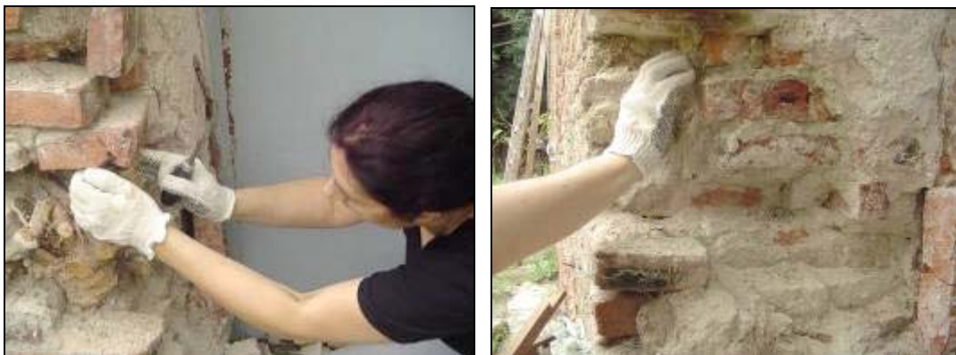
Figura 28: Extracción del tocón
